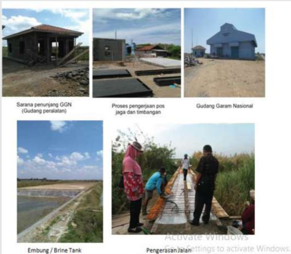
Gambar 13. Proses Pembangunan Gudang dan Sarana Pendukung
